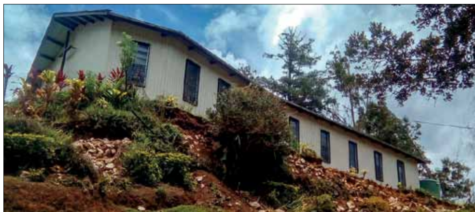
Lähetysaseman kirkkorakennus vaurioitui pahoin maanjäristyksessä 2018.
